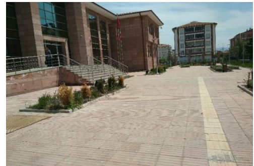
Fotoğraf 2: Doğru Bina Giriş Örneği
