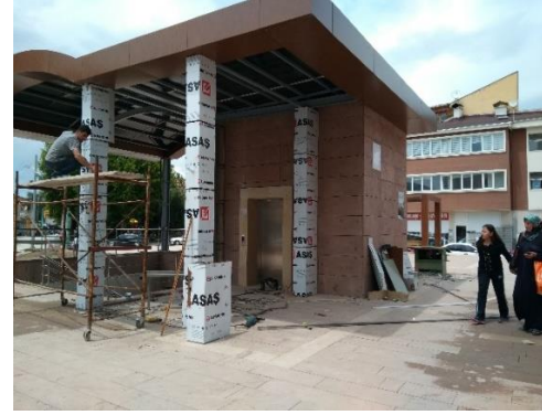
Fotoğraf 7: Kot Farklılığını Aşmada Asansör Çözümü
